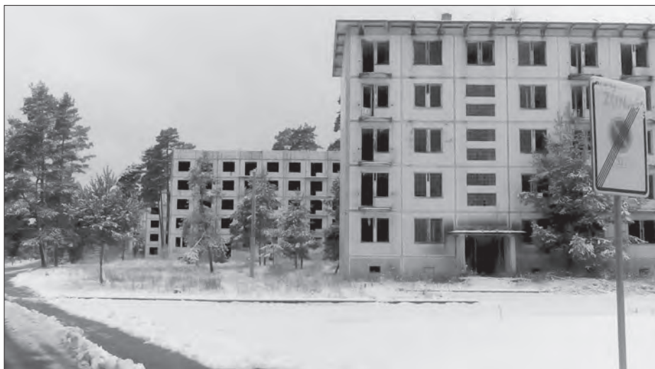
Část panelového sídliště po Sovětské armádě v Ploužnici v bývalém vojenském prostoru Ralsko. Domy vlastní město Mimoň, část jich nechalo rekonstruovat a nabízí zde levné byty sociálně slabým občanům. Postupně tak vzniká sociálně vyloučená lokalita, víceméně odříznutá od okolního světa (foto Barbora Spalová)
